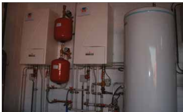
De installatie in de garage met de 2 hydroboxen en de tank voor sanitair warm water
