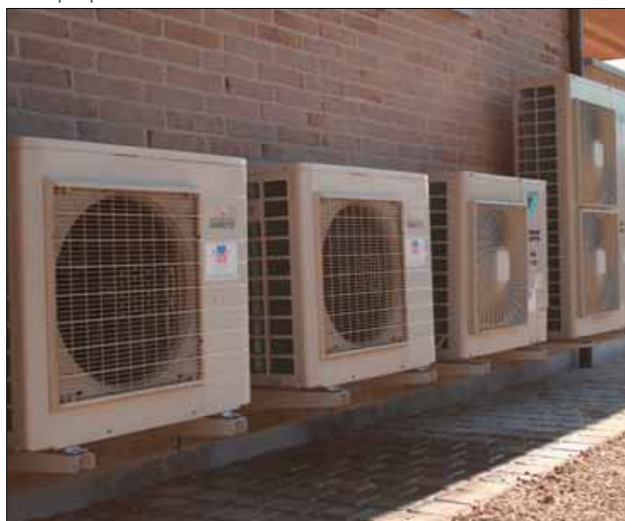
Twee buitenunits voor de twee Altherma units en de buitenunits voor de twee lucht-lucht-warmtepompen
